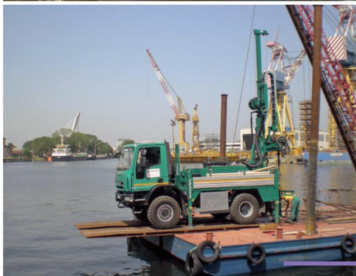
**Nel Canale Industriale Nord di Fincantieri del Porto di Marghera Geotecnica Veneta, utilizzando una Multidrill ML su autocarro, ha svolto un'indagine ambientale finalizzata alla campionatura dei sedimenti propedeutici a un futuro dragaggio del fondale.**
